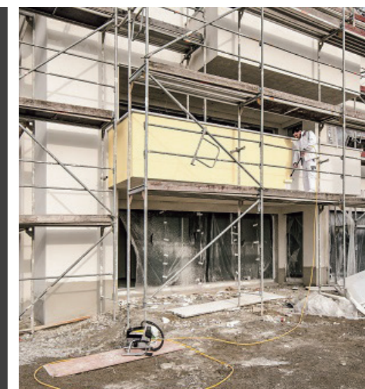
ピストン式エアレスポンプのイメージ
