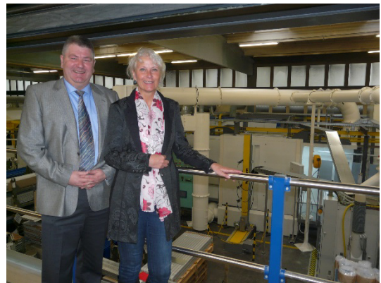
Die Geschäftsführung des Regalherstellers Jul. vom Hofe, Christian Jünemann und Christiane Sieper-Meyer, sind zufrieden mit der neuen Pulverbeschichtungsanlage von WAGNER.
