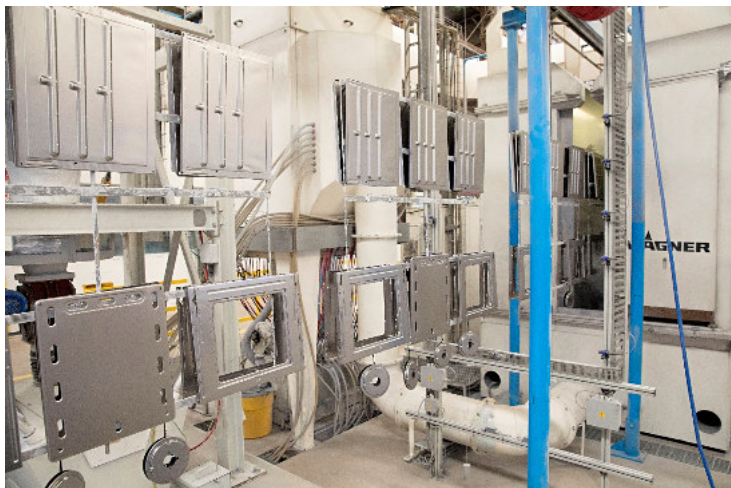
Werkstücke vor dem Eintritt in die Emaillie-Pulverbeschichtungskabine. Ein Sensor erfasst die Abmessungen der Werkstücke, um die genaue Positionierung der Automatikpistolen zu bestimmen. Das sorgt für den höchsten Auftragswirkungsgrad und einen wirtschaftlichen Einsatz des Emaillie-Pulverlacks.
