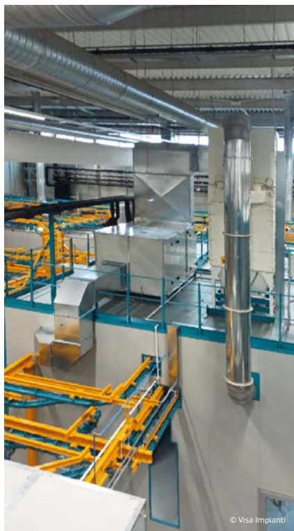
Da sinistra: panoramica del tunnel di pretrattamento; le cabine sono inserite all'interno di una clean room climatizzata; la cabina Super Center Evo di Wagner.
