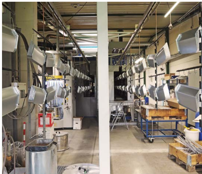
Die Anlage ist auf engstem Raum installiert.
