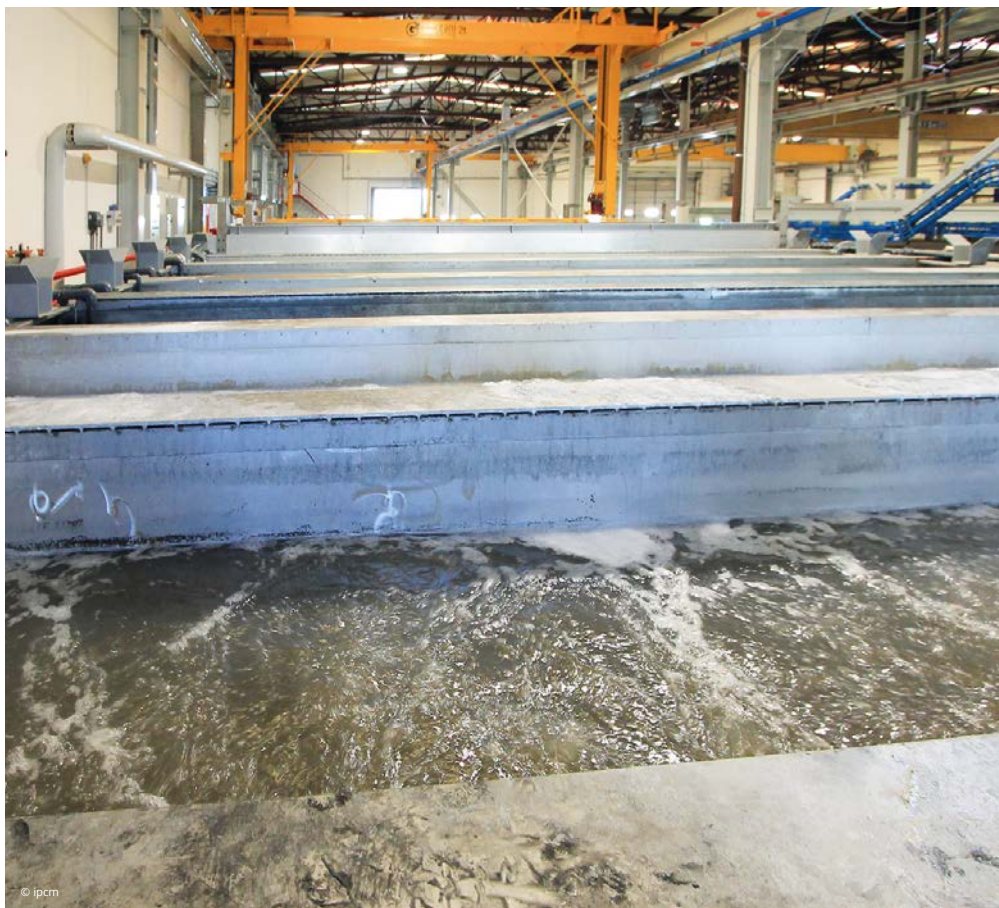
Dettaglio di una delle vasche per il pretrattamento dei manufatti in alluminio.
