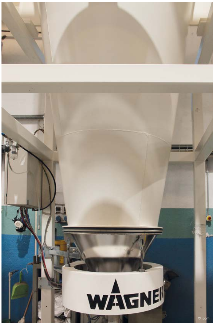
Il ciclone per il recupero della polvere.
