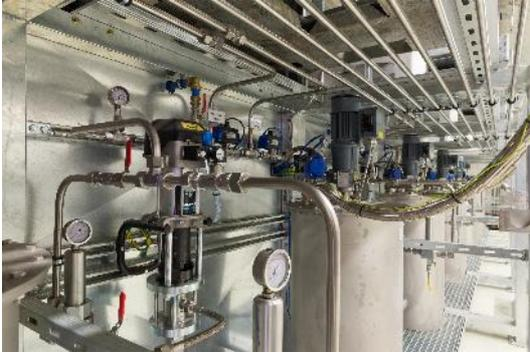
Sept pompes WAGNER de type Puma 8-300 transportent les composants à faible pression de la salle d'alimentation en peinture jusqu'aux cabines de peinture. Afin de compenser les distances importantes, Thüma a installé un concept innovant de circulation en boucle avec commutation entre la conduite d'amenée et la conduite de retour.
