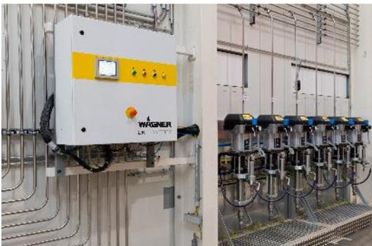
Cada uno de los sistemas automáticos de mezcla y dosificación del tipo 2K COMFORT se dotó de forma adicional de una bomba de pintura especial para Liebherr, la cual añade a la mezcla de imprimación cantidades reducidas del barniz de acabado que se aplicará después para optimizarlo y darle un acabado más brillante.
