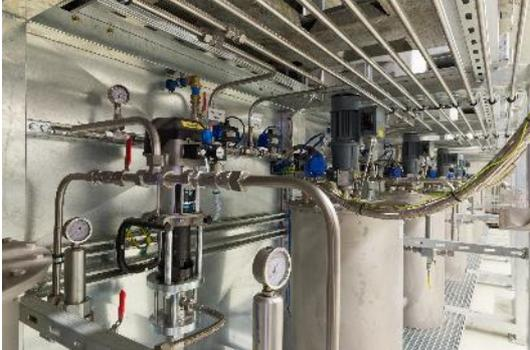
Siete bombas de WAGNER de tipo Puma 8-300 transportan los componentes a baja presión de la sala de suministro de pintura hasta las cabinas de barnizado. Para poder salvar las grandes distancias, Thüma ha instalado un innovador concepto de conductos anulares con una conmutación entre el tubo de avance y retroceso.
